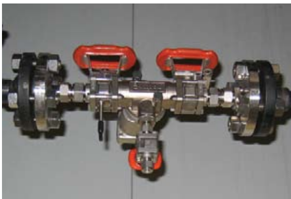
شکل ۲- یک نمونه آرایش نصب تله بخار
