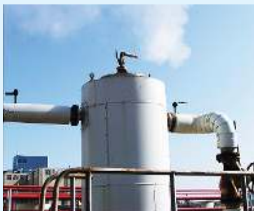
شکل ۲- مسیر تخلیه بخار مجهز به شیر دستی در یک سامانه هوزدا
