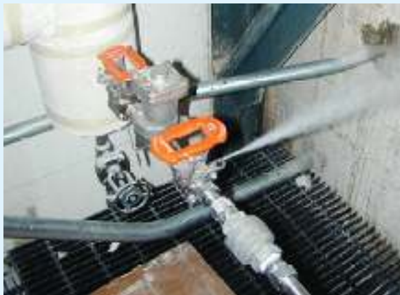
شکل ۲- آزمون عملکرد یک تله بخار از طریق شیر آزمون
