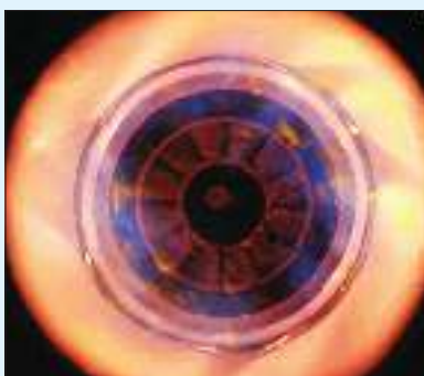
شکل ۳- نمایی از یک مشعل دیگ بخار (در حال کار)
