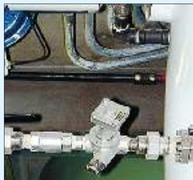
شکل ۱- یک نمونه مسیر بخار مجهز به تله بخار
